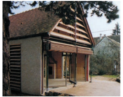
Habitations de composition simple, l'une avec un pignon s'ouvrant ou se fermant par un système de volets, l'autre offrant un auvent servant d'abri voiture
