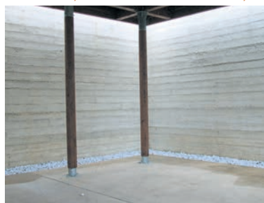
Préau aux Clayes-sous-Bois, archi. Anne Delaunay
