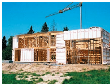
Chantier d'une maison à ossature bois
