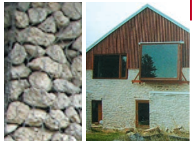
Matériaux : résilles métalliques pour plantes grimpantes, mur en gabion (caisson en treillage métal rempli de caillasse), pignon en moellon enduit à pierre vue et clins de bois associés aux fenêtres cadrées
